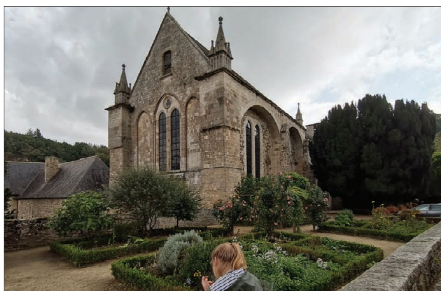
Fig. 396 : Église abbatiale de Léhon dans la commune nouvelle de Dinan
