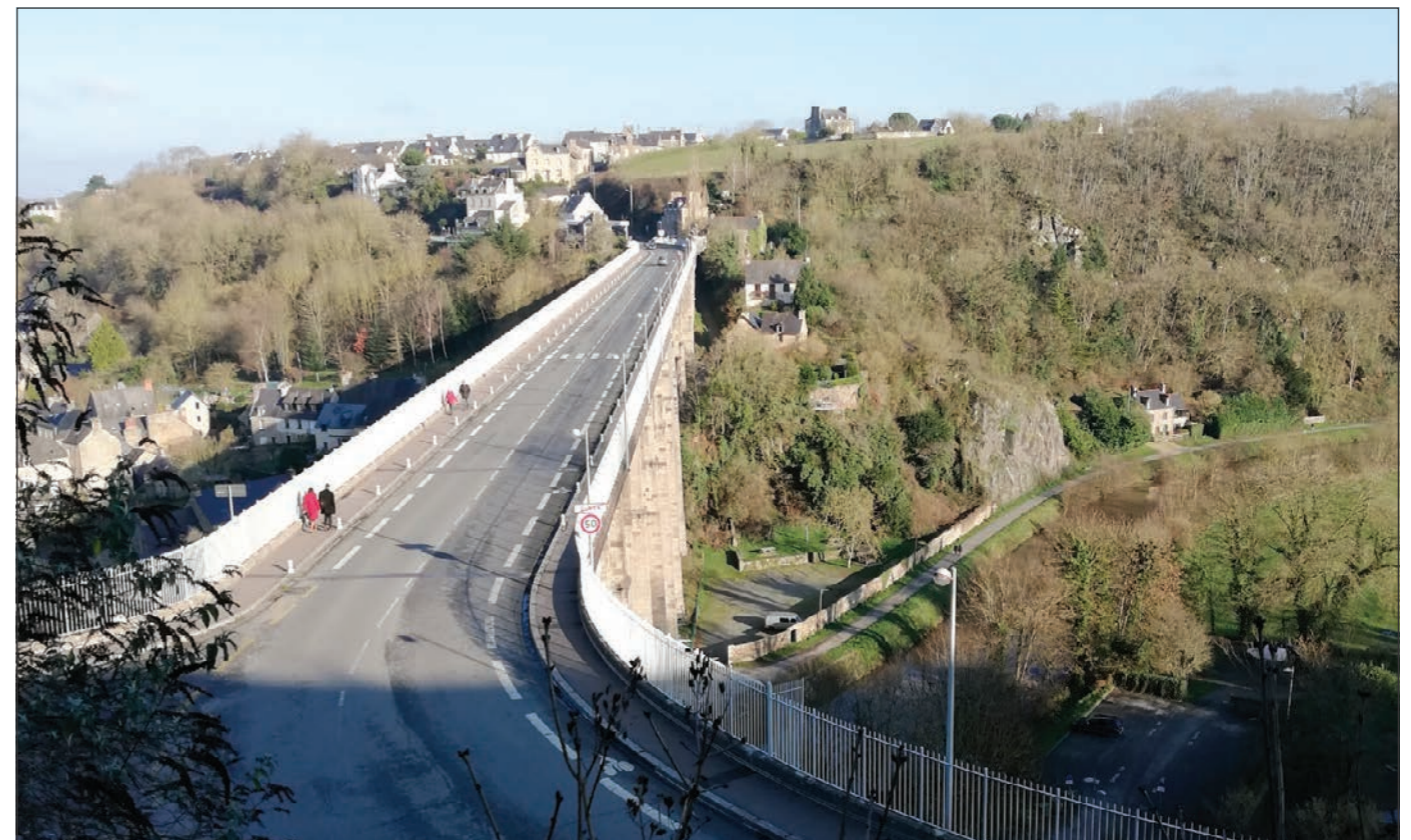
Fig. 392 : Traversée piétonne du viaduc entre Dinan et Lanvallay
